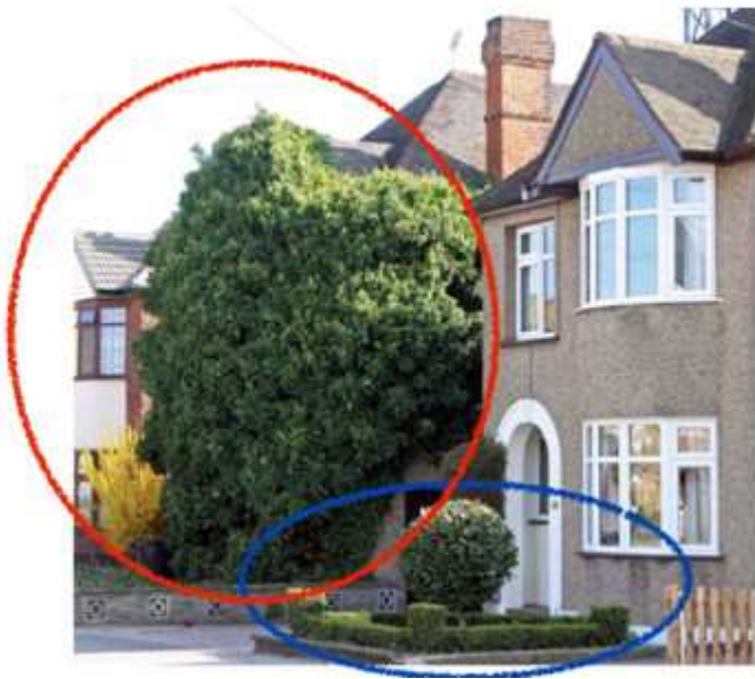
Fig. n. 13: Vegetazione che impediva la visuale alle finestre e alle porte di accesso alle abitazioni
